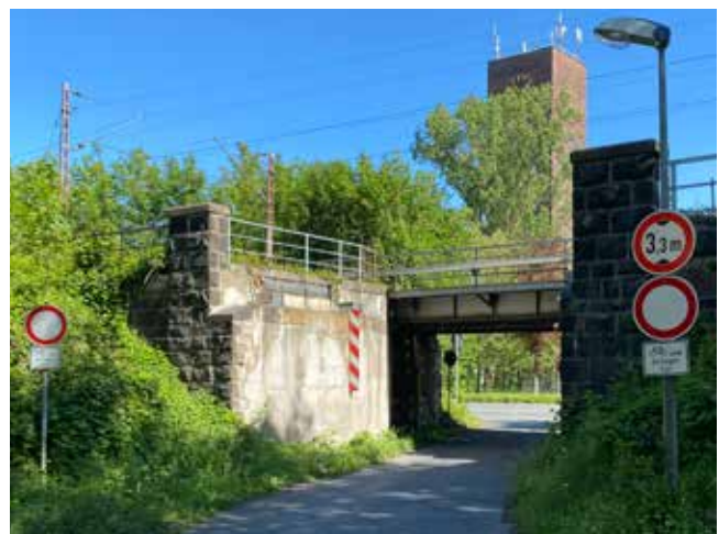
Bahnunterführung „Zum Stummhafen“
