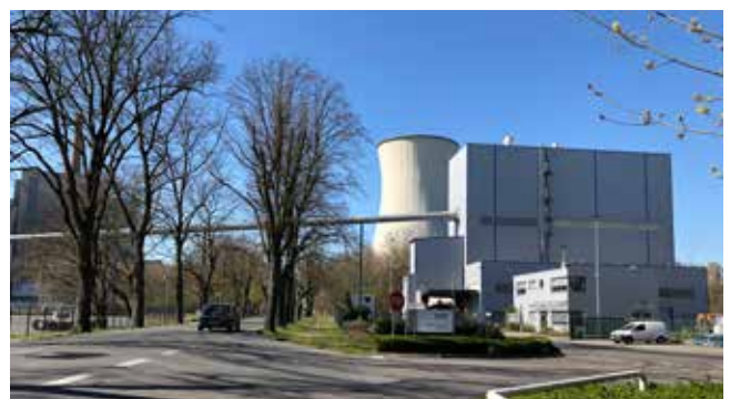
Förderband von STEAG Power Minerals über die Moltkestraße
