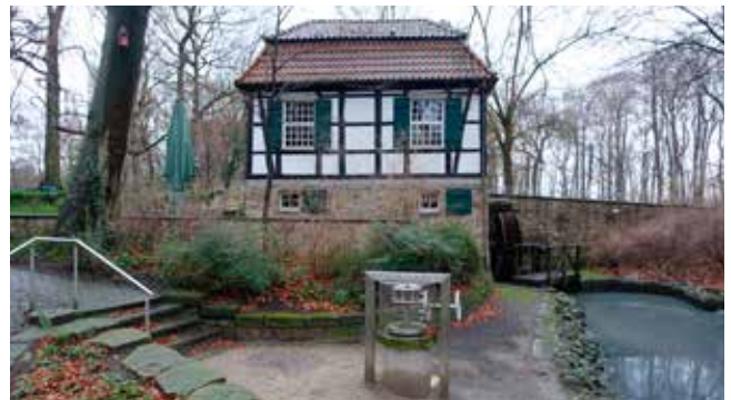
Schlossmühle an der Brunnenstraße
