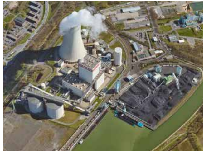
Stummhafen und Trinanel-Kraftwerk (Quelle: Kreis Unna, 2019)
