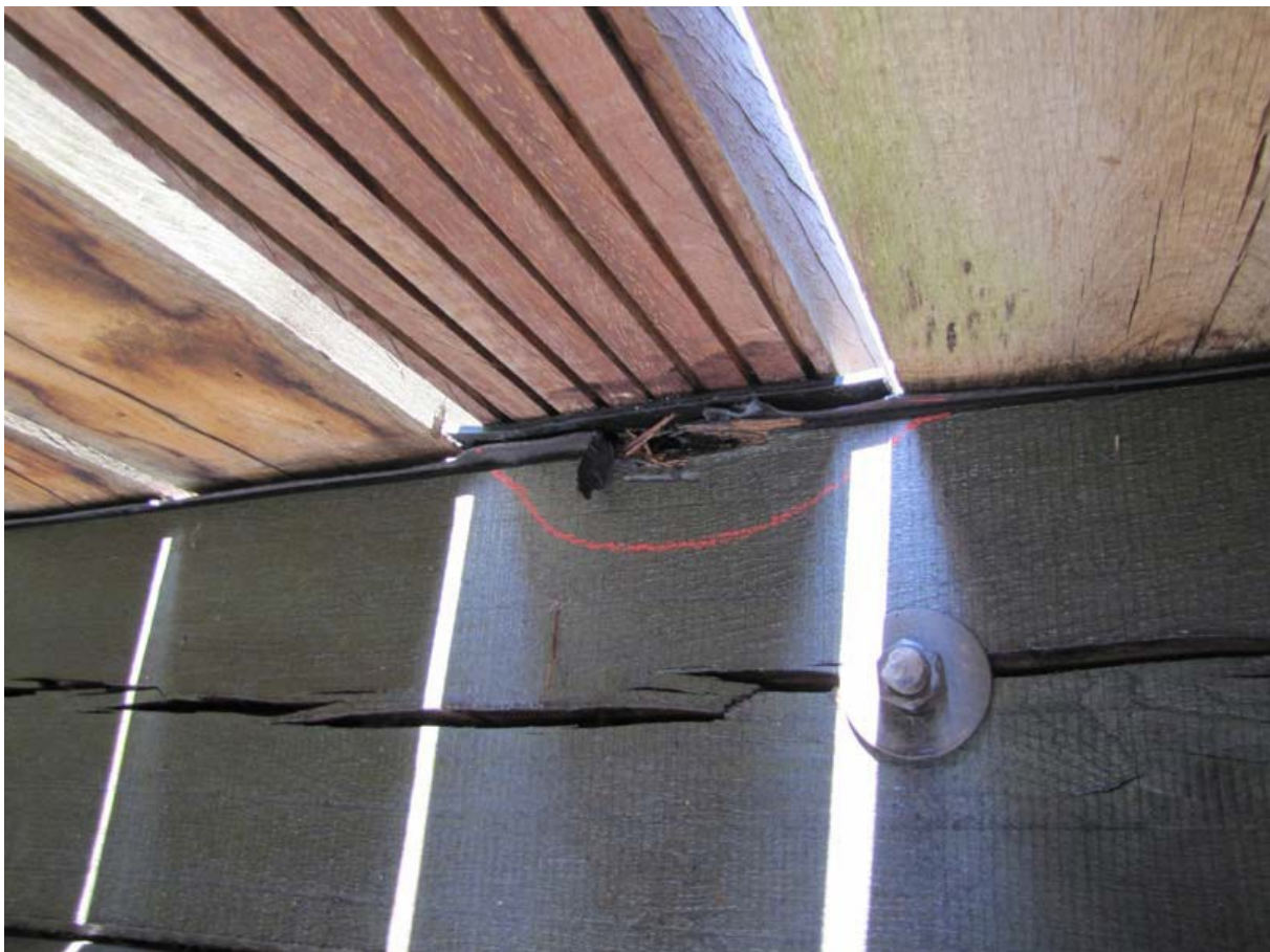
Bild 10: Austauschbohle mit dickerer Bitumenpappe
