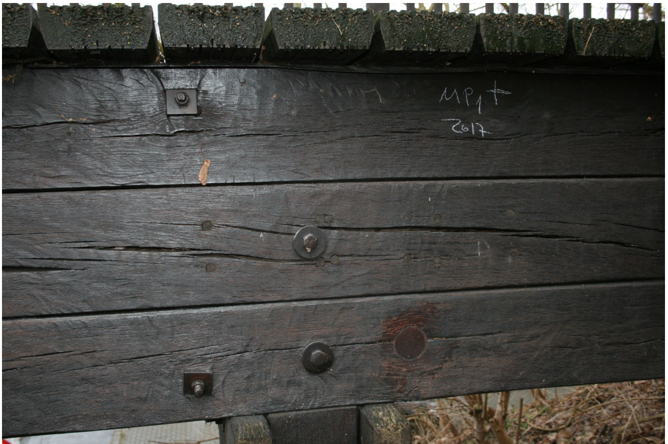
Bild 16: Lage Messstelle 1 über der Stützung, Endfeld, östlicher Träger
