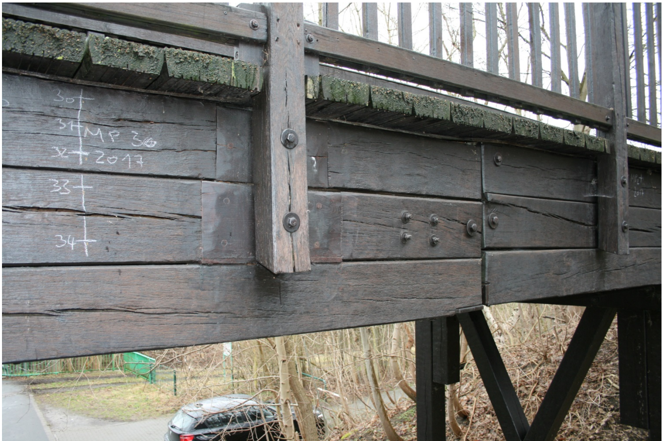
Bild 21: Lage der Bohrungen 30 – 34 im eingehängten Träger
