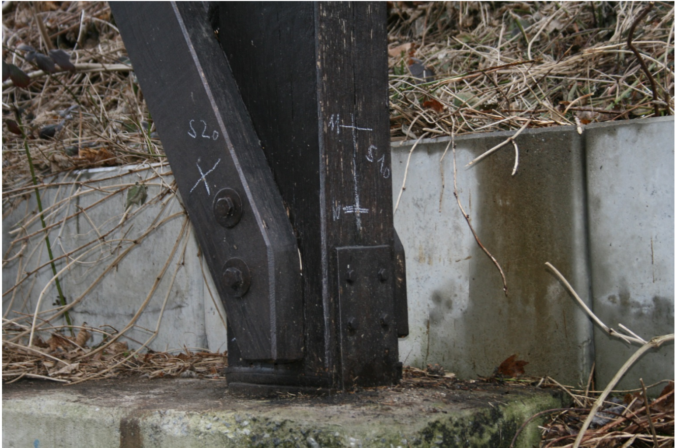
Bild 43: Übersicht über die Bohrungsstellen S10, S11 und S20 am Stützenfuss
