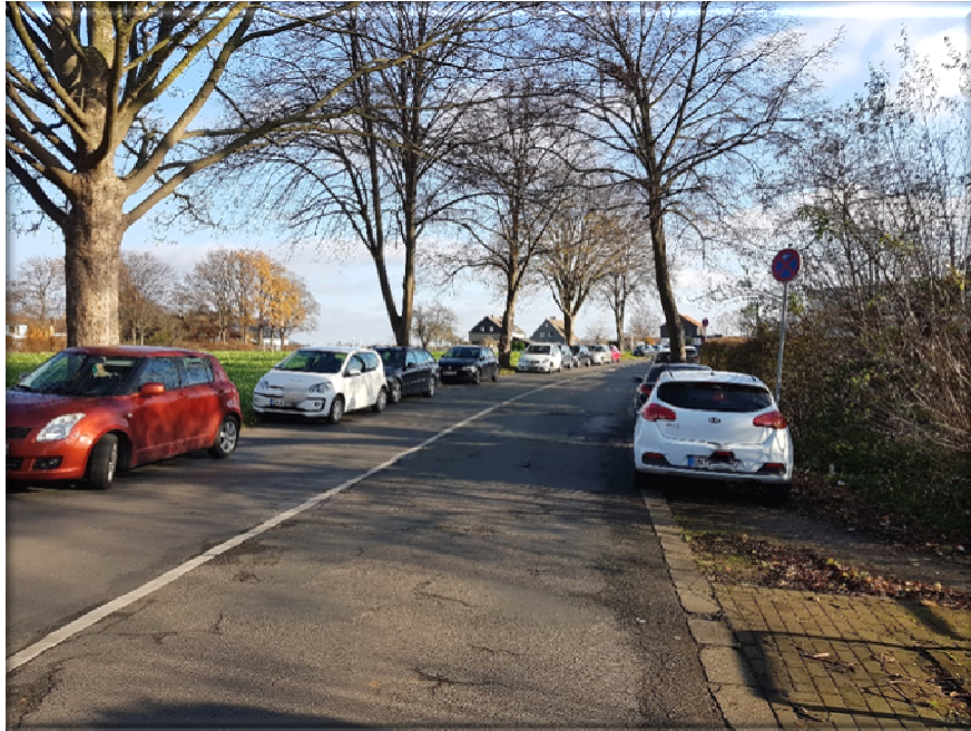
Fahrtrichtung Osten Kamen/ Bergkamen/ rechts Graben/ Bankett als Notgehweg hergestellt und absolutes Parkverbot gemäß VZ 283 StVO.
