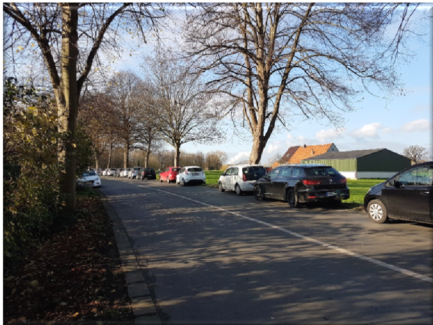
Fahrtrichtung Westen Lünen-Horstmar, VZ 295 StVO aufgebracht, links parkender Pkw unbefestigte Bankett/ vormaliger Graben
