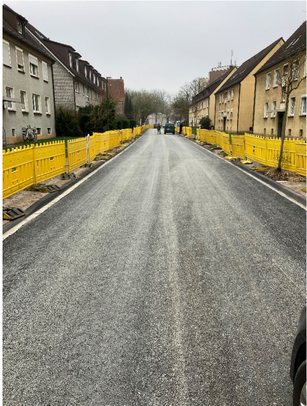
Virchowstraße - fertiggestellte Asphaltdeckschicht
