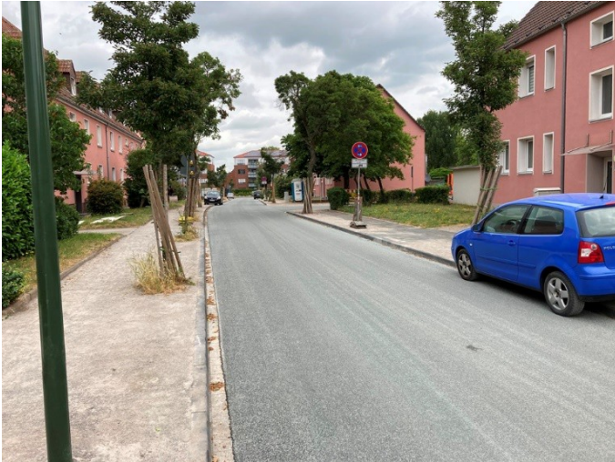
Röntgenstr. fertiggestellte Asphaltdeckschicht
