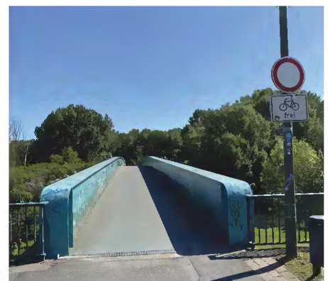
Fußgängerbrücke über die Lippe
