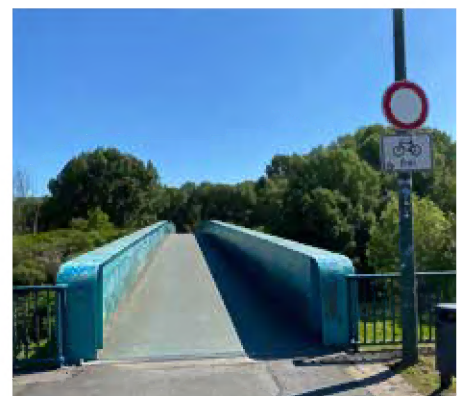
Fußgängerbrücke über die Lippe
