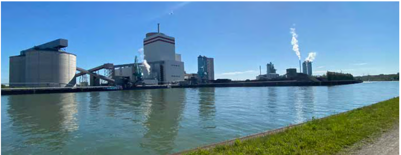
Trianel-Kraftwerk und Stummhafen am Datteln-Hamm-Kanal
