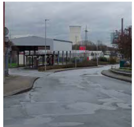
Unattraktiver Straßenraum Frydagstraße
