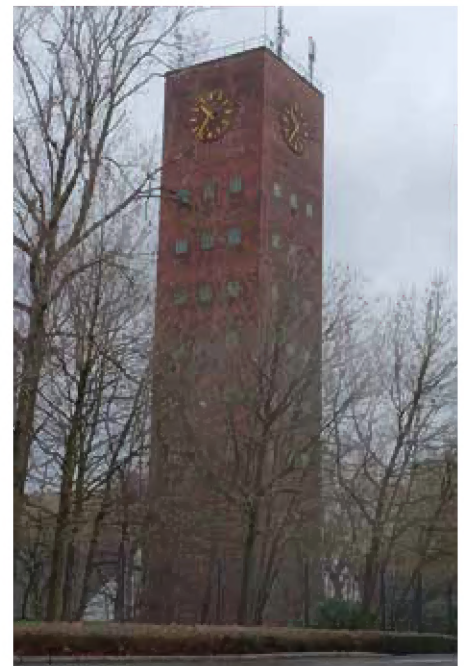
Wasserturm auf dem Gelände der Fa. REMONDIS
