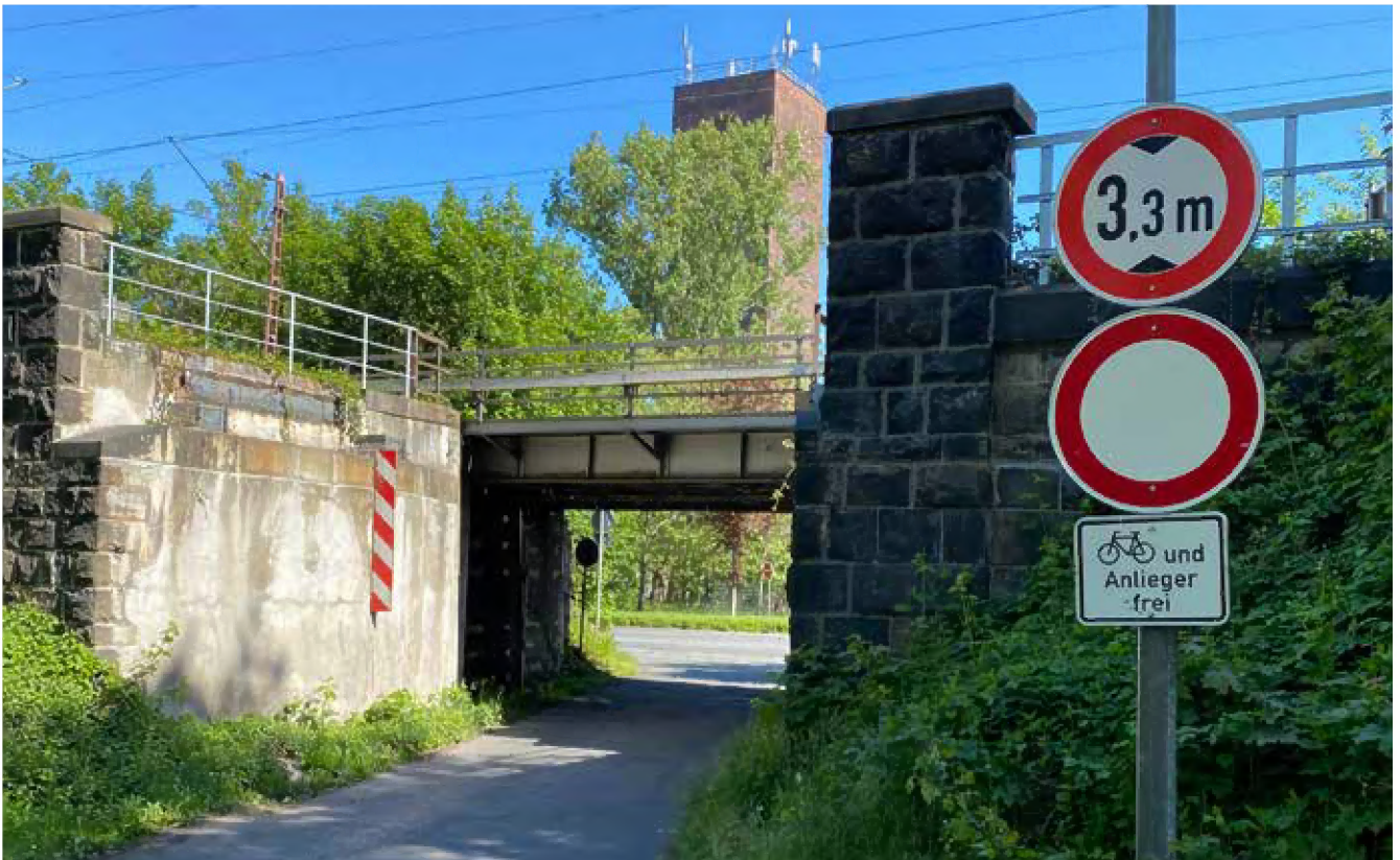
Bahnunterführung „Zum Stummhafen“
