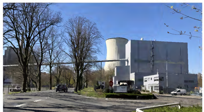
Förderband von STEAG Power Minerals über die Molikastaße
