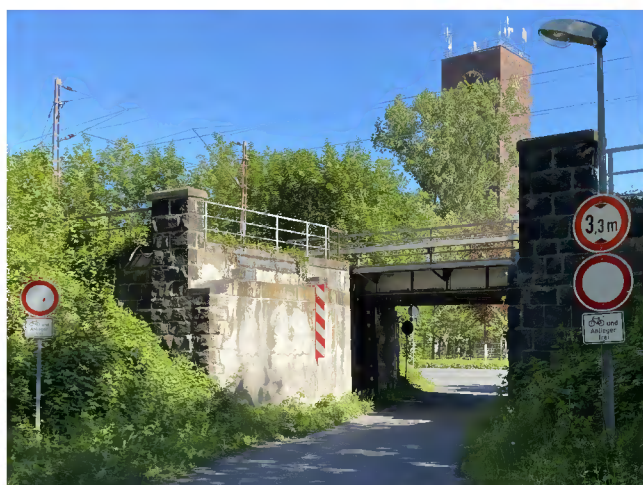
Bahnunterführung „Zum Stummhafen“
