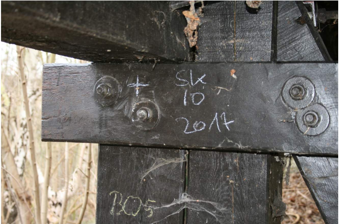
Bild 41: Lage der Bohrungsstelle SK 10 am Stützenkopf
