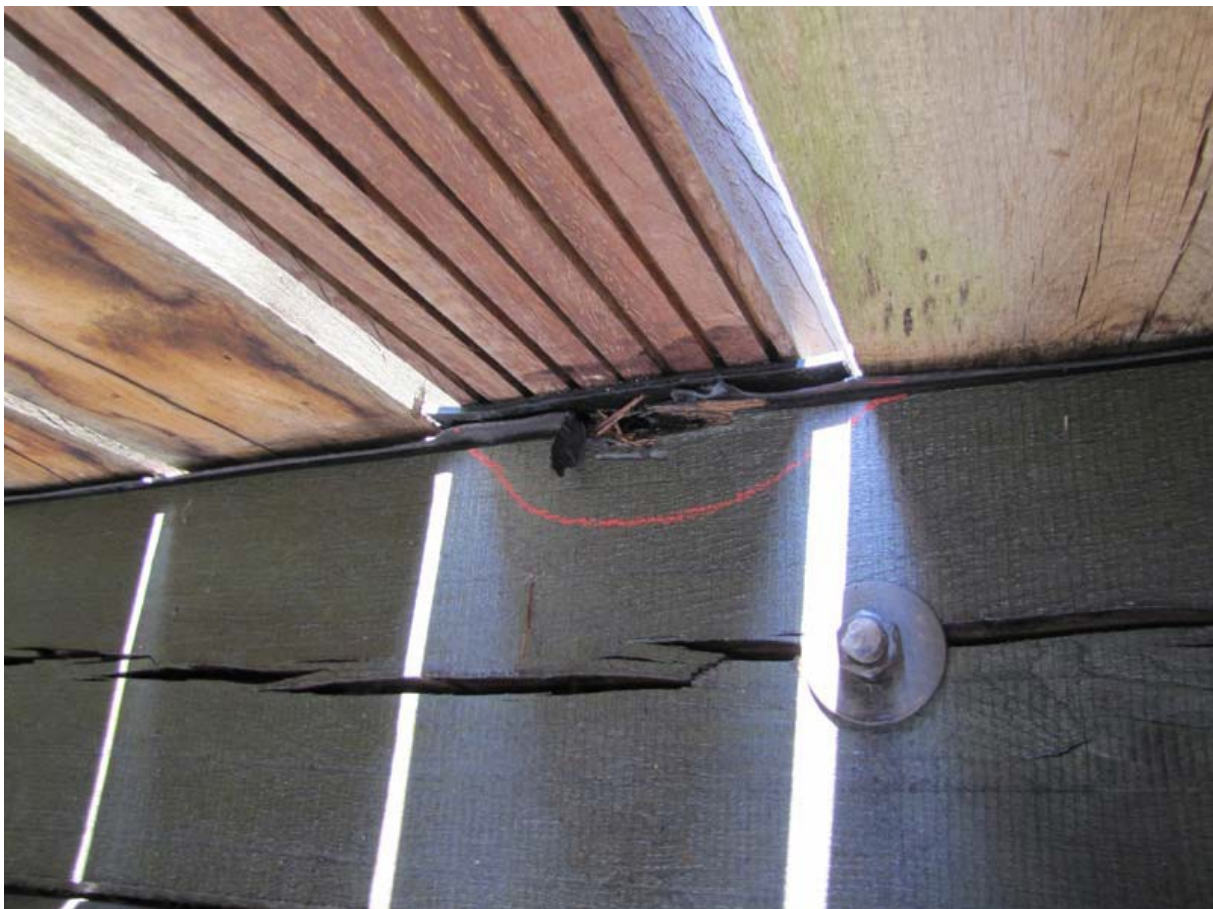
Bild 10: Austauschbohle mit dickerer Bitumenpappe
