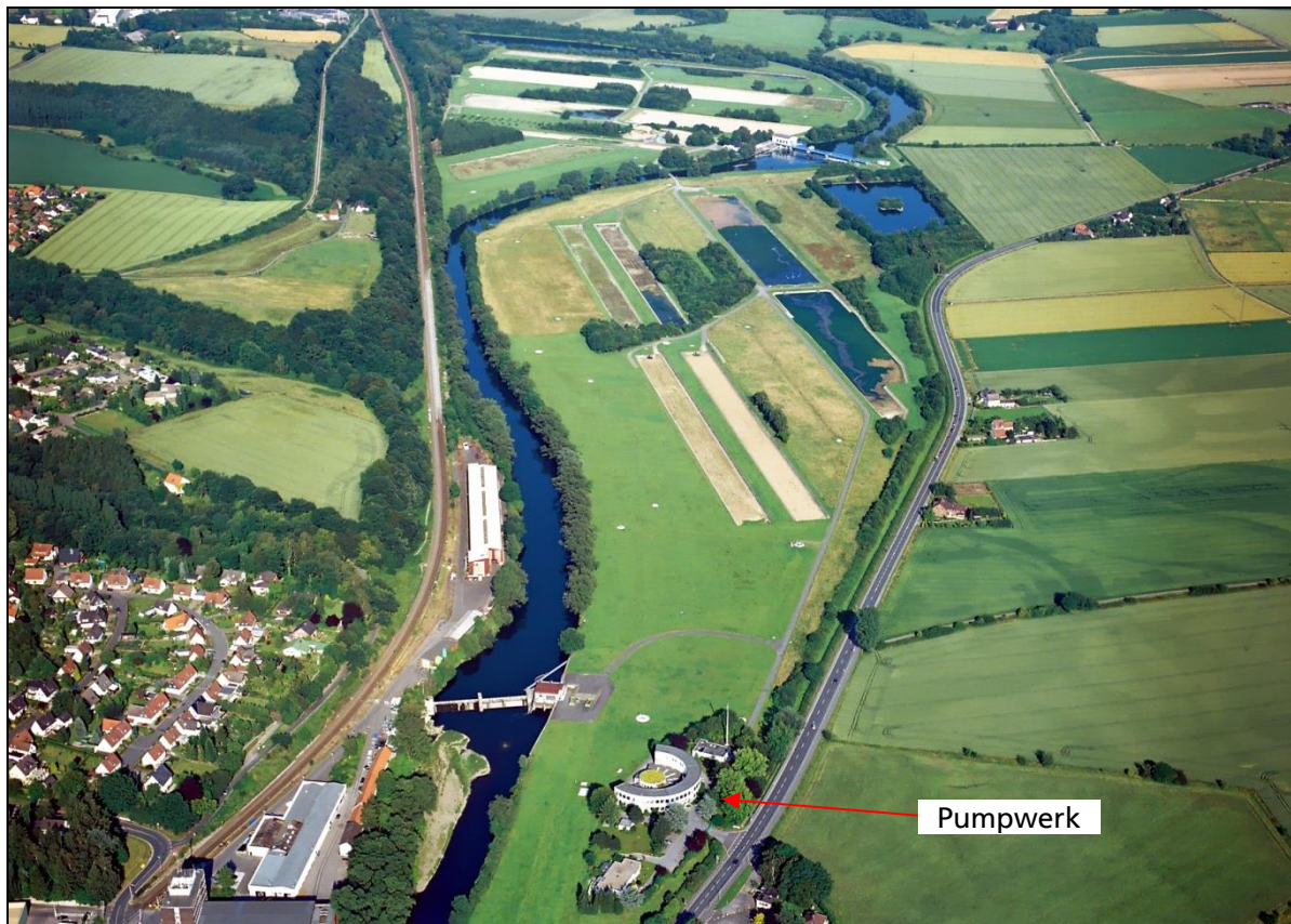
Abbildung 3: Wasserwerk Halingen – Pumpwerk und Wassergewinnungsgelände
