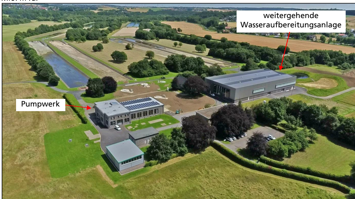
Abbildung 5: Wasserwerk Echthausen - Wassergewinnungsgelände, Pumpwerk und Wasseraufbereitungsanlagen
