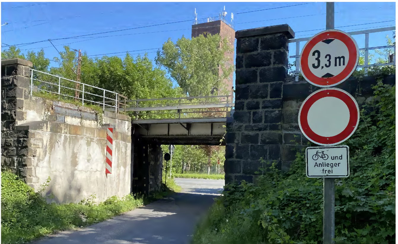
Bahnunterführung „Zum Stummhafen“
