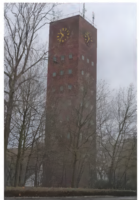
Wasserturm auf dem Gelände der Fa. REMONDIS
