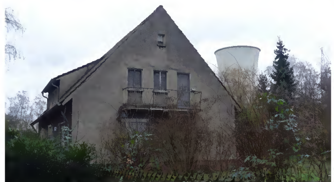
Leerstehendes Wohnhaus der ehemaligen Werkssiedlung Am Lünen Brunnen
