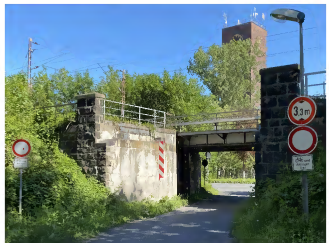
Bahnunterführung „Zum Stummhafen“
