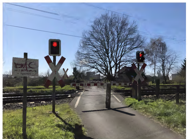
Bahnübergang Mühlenweg, Blick nach Süden
