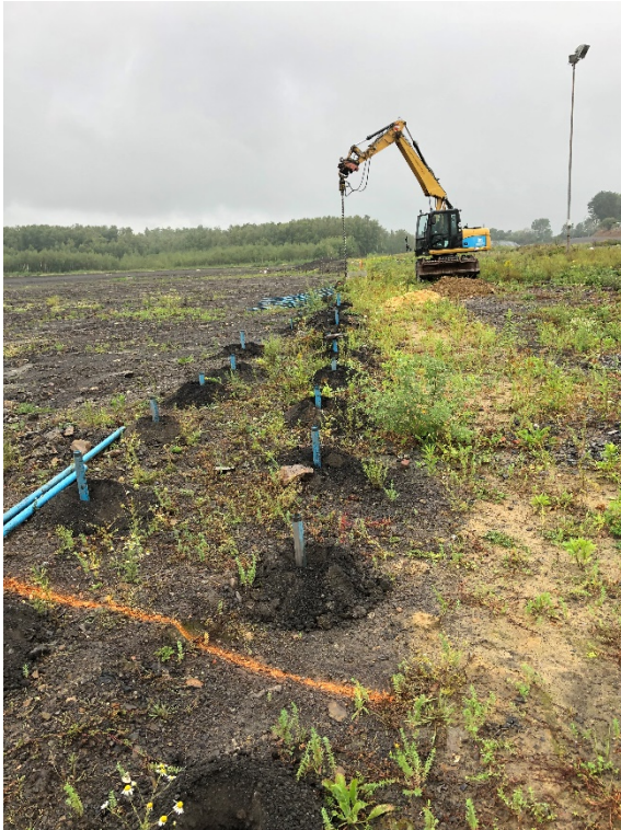
Zwolle Allee - Baustraße Forensik - Sondierungsarbeiten
