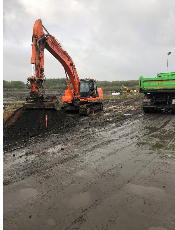
Zwolle Allee - Baustraße Forensik - Erdarbeiten
