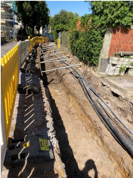
Augustastraße – Versorgungsleitungsbau zwischen Turnhalle und Glückaufstraße
