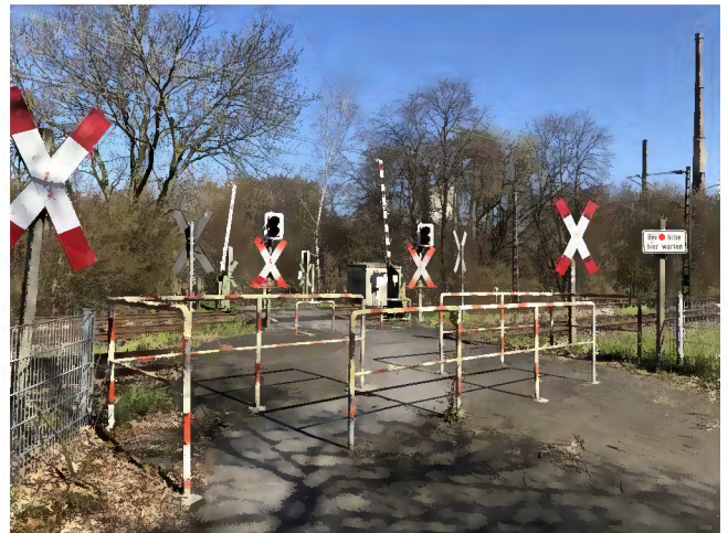
Bahnübergang Mühlenweg, Blick nach Norden
