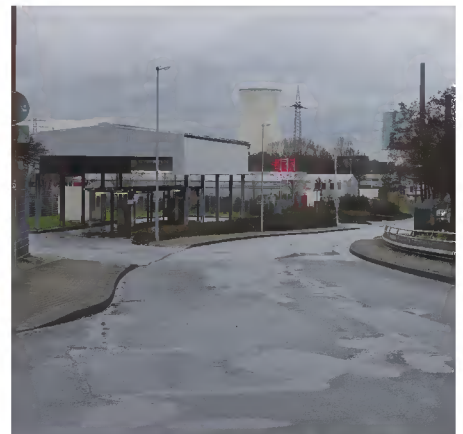
Unattraktiver Straßenraum Frydagstraße
