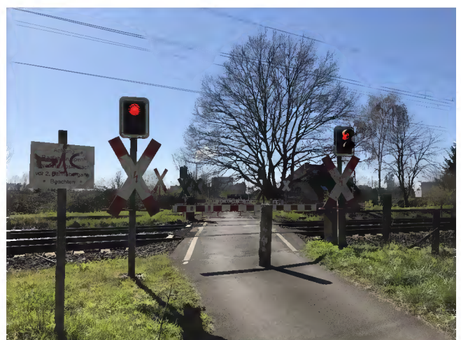
Bahnübergang Mühlenweg, Blick nach Süden
