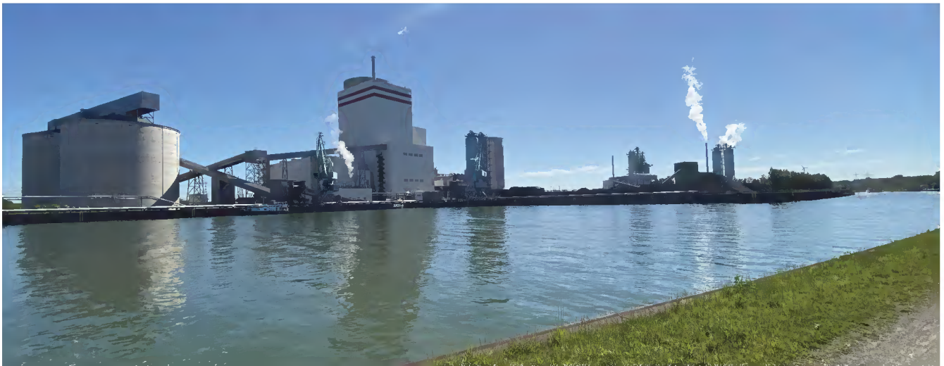
Trianel-Kraftwerk und Stummhafen am Datteln-Hamm-Kanal
