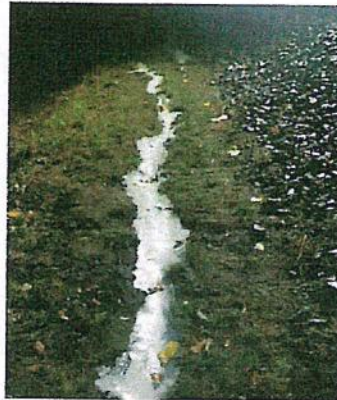
Verfüllen mit Betonsuspension
