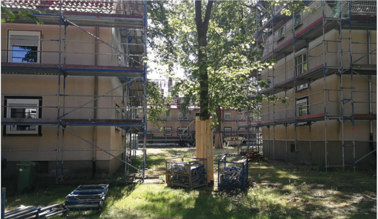
Abb. 107: Sanierungstätigkeiten in Brambauer III
