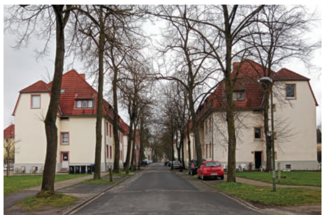
Abb. 38: Gebäude der Alten Kolonie in der Gustavstraße
