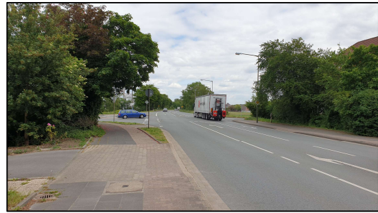
Abb. 2, Foto Blickrichtung Osten
