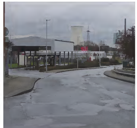
Unattraktiver Straßenraum Frydagstraße
