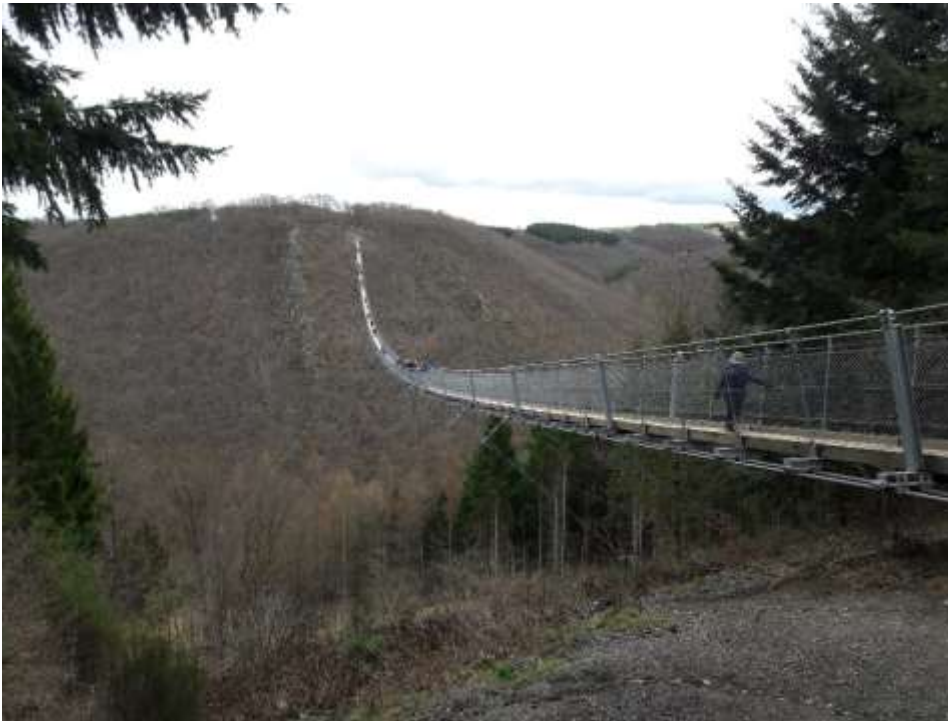
Beispiel Hängebrücke; Foto:MSP
