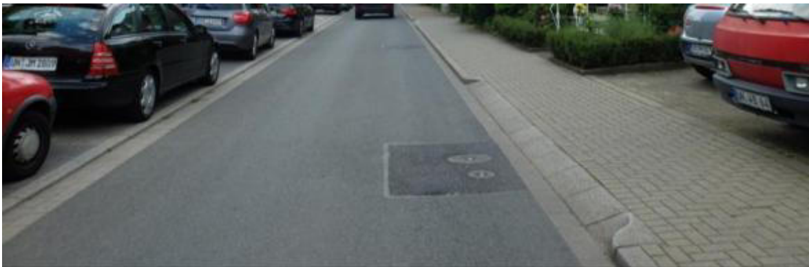
Abbildung 20: oben: Beispiel für eine weiterlaufende Pflasterung des Radwegs gegenüber untergeordneten Straßen; unten: Beispiel für einen Rampenstein an Grundstückszufahrten
