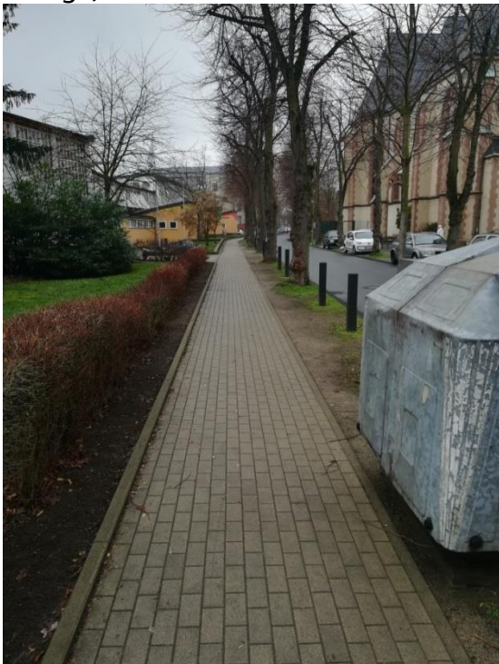
Bild 6: Sanierter Gehweg Südseite
