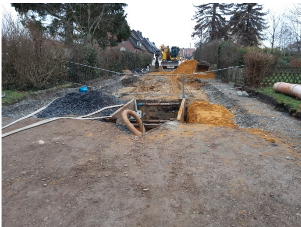
Versorgungsleitungen und Kanalbau
