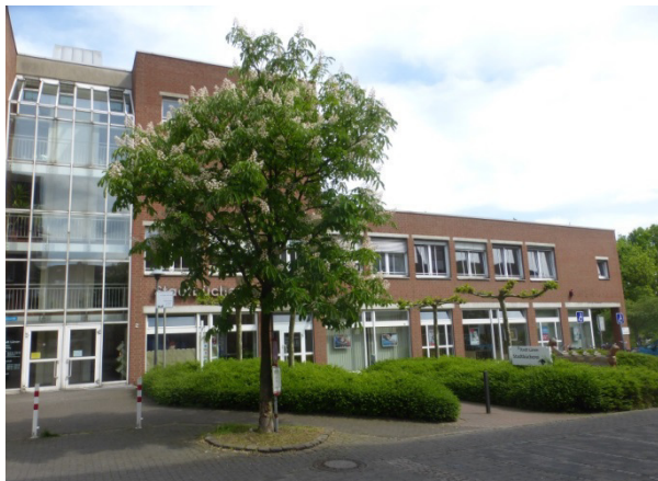
Der Eingang der Bücherei ist, von der Fußgängerzone kommend, nahezu unsichtbar.
