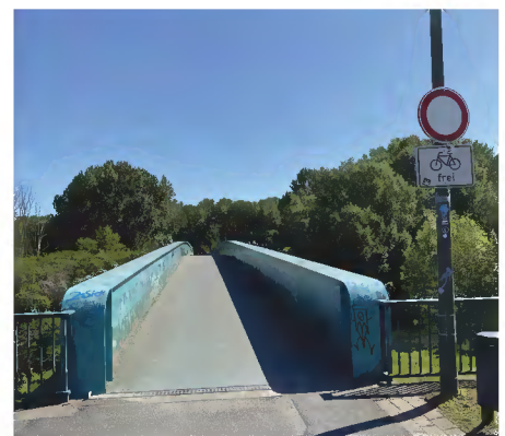
Fußgängerbrücke über die Lippe
