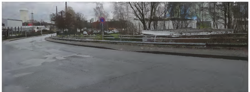
Unattraktive Wegeverbindungen entlang der Frydagstraße
