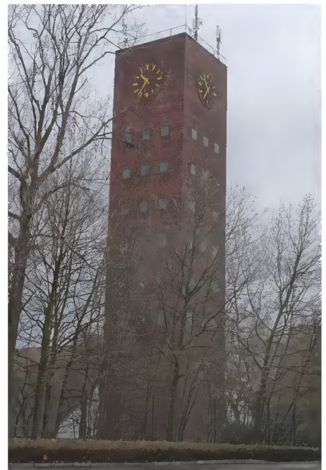
Wasserturm auf dem Gelände der Fa. REMONDIS
