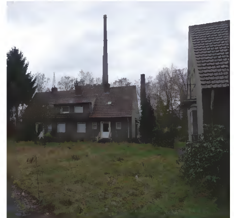
Leerstehende Wohnhäuser Am Lüner Brunnen
