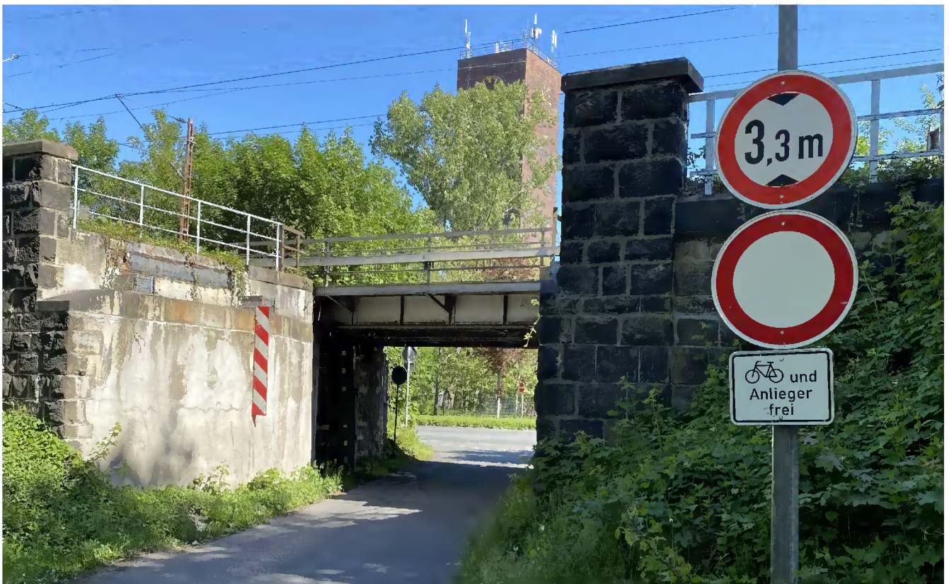
Bahnunterführung „Zum Stummhafen“
