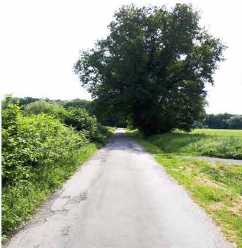
Bestandsfoto: Schottweg Richtung Südpark
