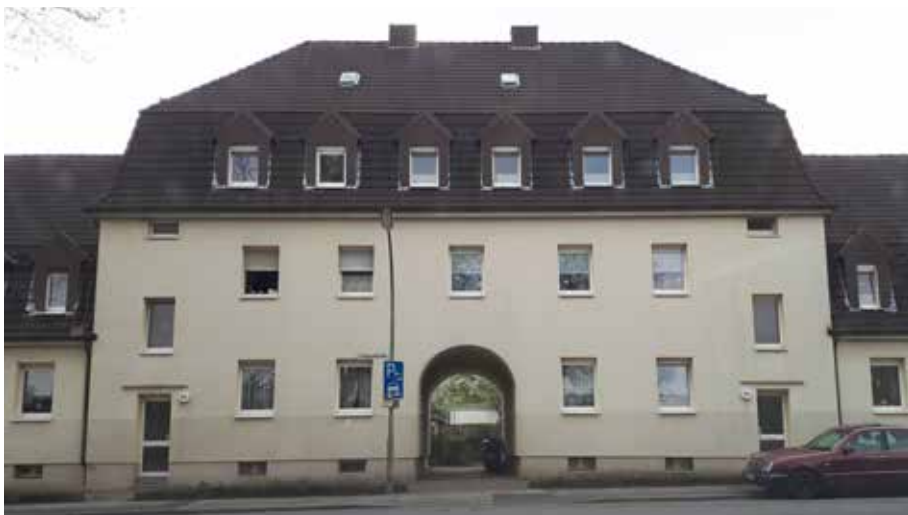
Foto: Gebäude an der Freiligrathstraße
