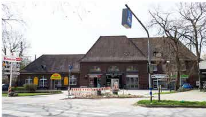
Bahnhofgebäude mit Vorplatz
