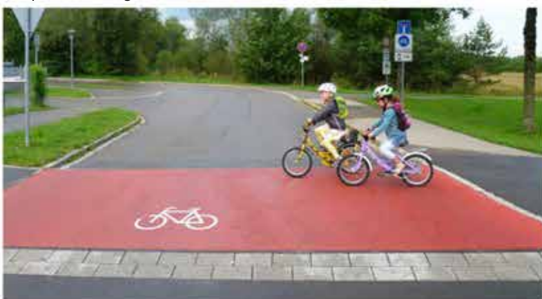
Beispielbild farbiger Asphalt und Höhenangleichung in Fahrbahn
