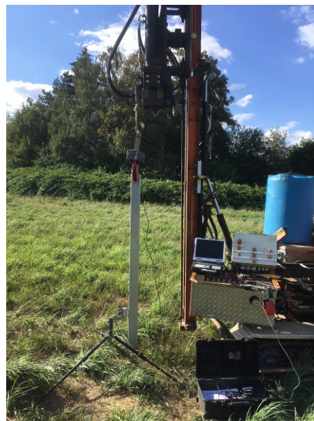
Vorbereitung axialer Zugversuch
